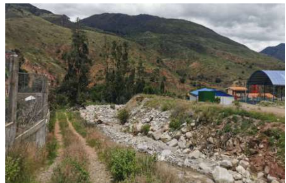
FOTOGRAFIA N°02: Verificación de la altura de talud en el margen izquierdo Y derecho del río illaura , que viene erosionándose fluvialmente afectando zonas de viviendas.
